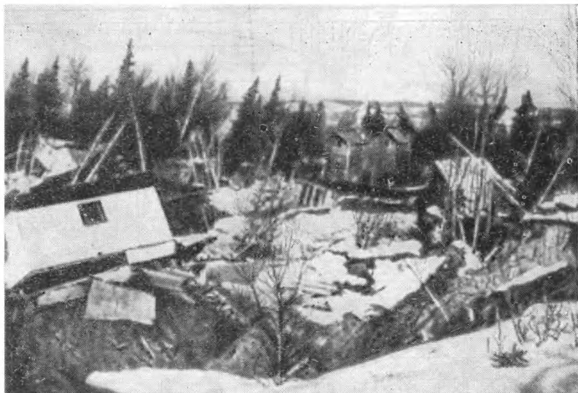
Фото 1.1. Дома, разрушенные в результате крупного оползня в Тернагейне при Аляскинском землетрясении 1964 г.
