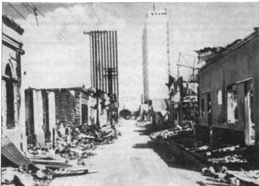
Фото 1.2. Пример резкого различия в степени повреждений при землетрясении 1972 г. в Манагуа.
