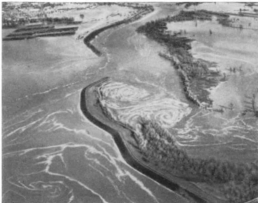
Фото 7.7 Прорыв ограждающей дамбы на реке Фетер, Калифорния, у города Юба-Сити во время наводнения в декабре 1955 г.
