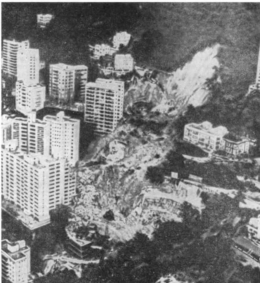
Фото 4.1. Обрушение склона в Гонконге.
