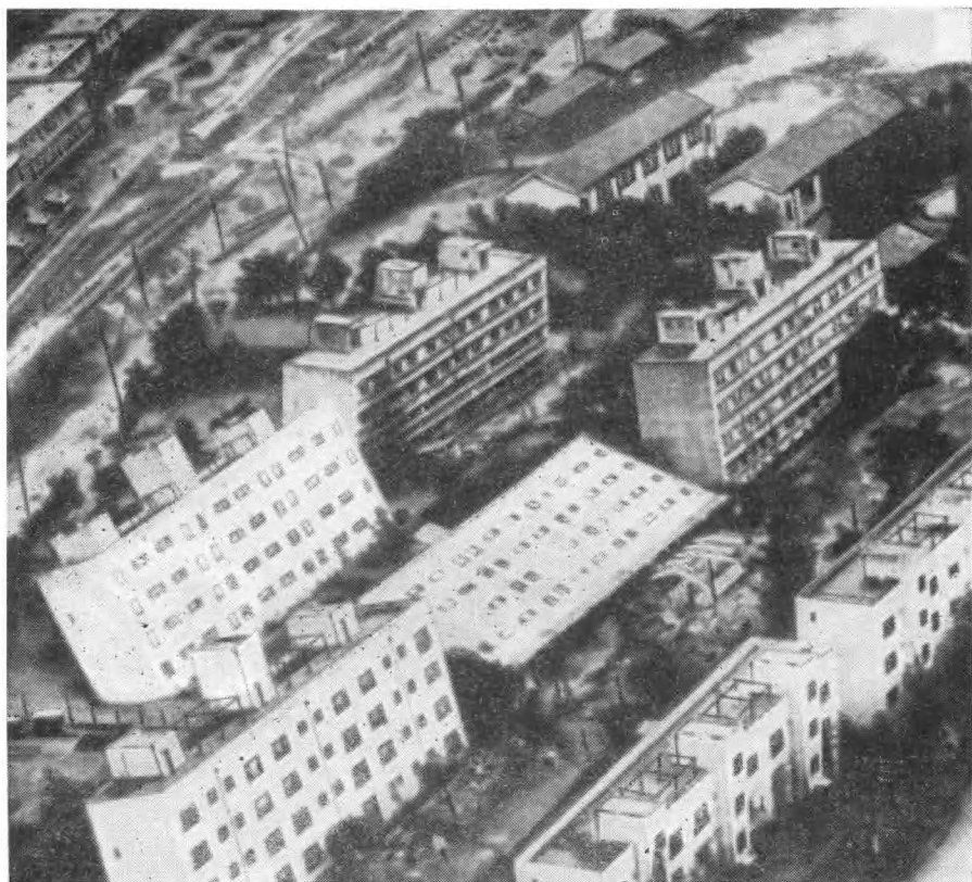
Фото 1.4. Разжижение водонасыщенных песков при землетрясении 1964 г. в Ниигата привело к наклону жилых домов.
