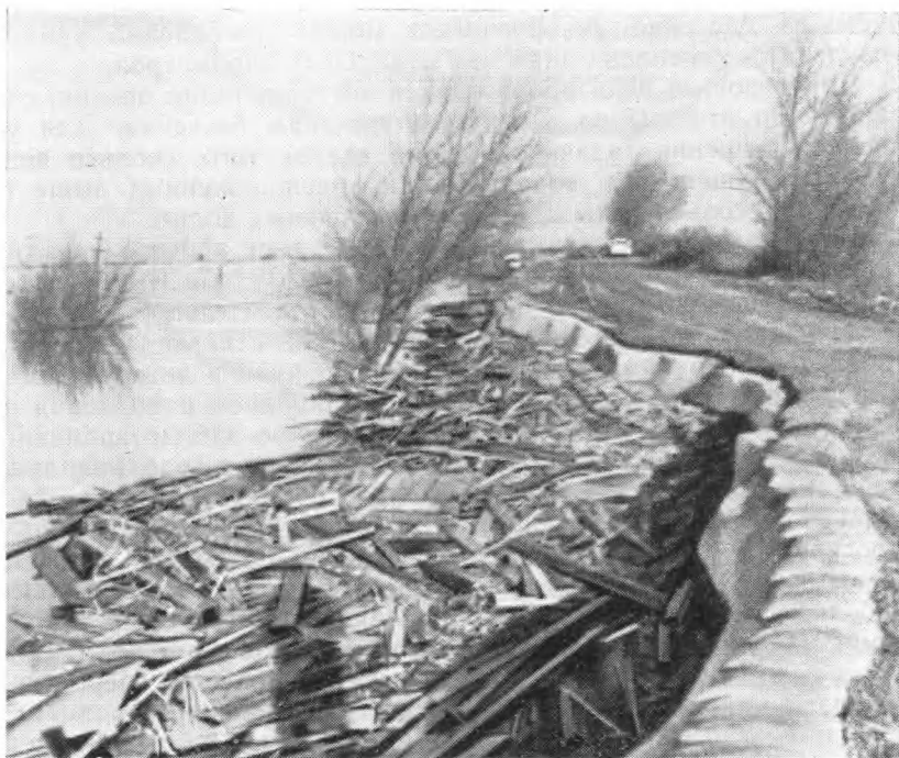
Фото 7.9. Ремонтные работы на дамбе вдоль острова Шерман, Калифорния.
