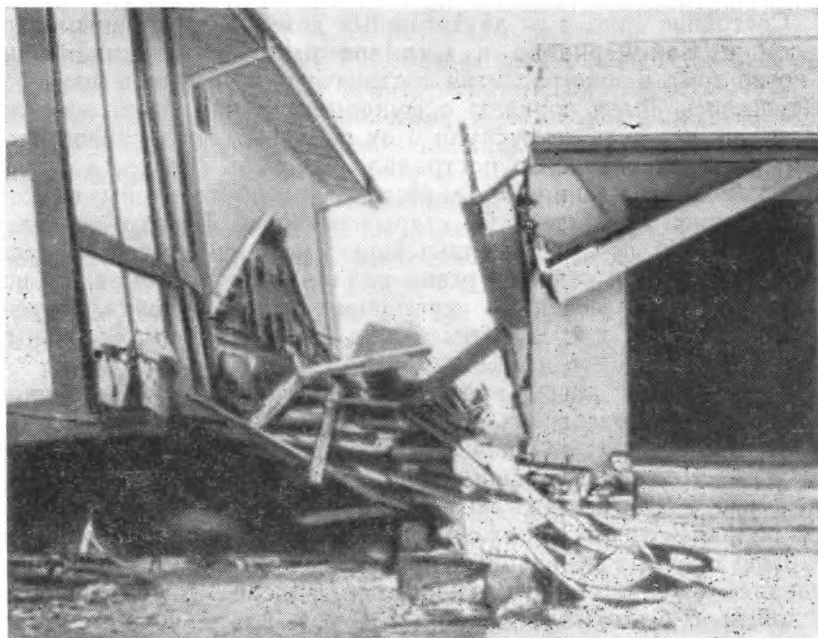
Фото 1.7. Двухэтажное крыло нового разноэтажного дома рухнуло при землетрясении Сан-Фернандо (1971 г.), раздавив стоявший в гараже автомобиль.
